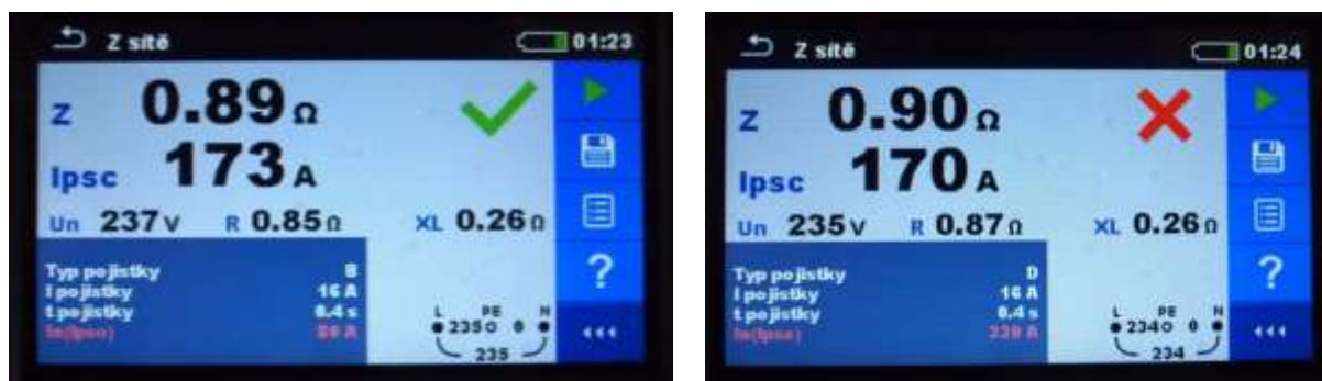
Obr. 14 – Automatické vyhodnocení měření impedance přístrojem EUROTTEST XC
